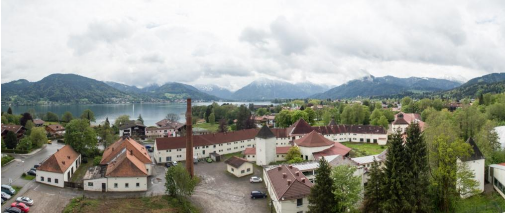
Jod-Schwefelbad vor dem Abriss (Foto: Renate Zinser)
